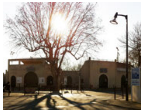
Carrefour de la rue des Mûriers avec la RD262
