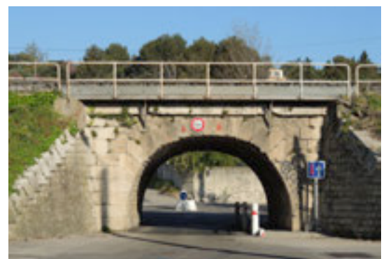
Carrefour rue des Cèdes/rue des Mûriers
