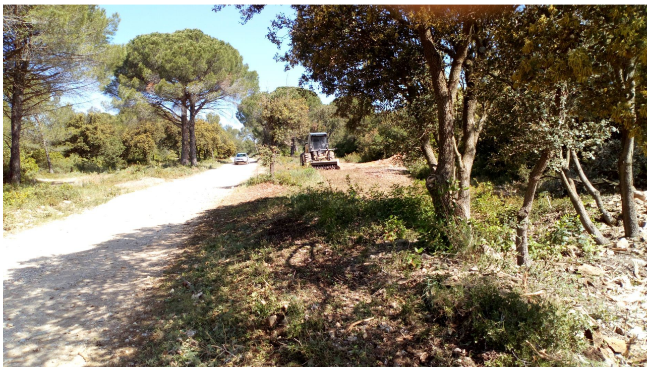
Travaux de débroussaillage réalisé sur piste DFCI B 103 commune de Caveirac
