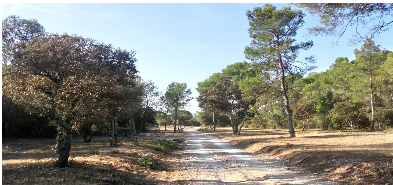
Travaux de débroussaillage réalisés sur piste DFCI B 15 commune de Clarensac
